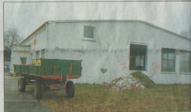
Bald nur noch ein Schutthaufen: Die ehemalige Kfz-Werkstatt an der Haldemer Hauptstraße wird komplett abgerissen.
